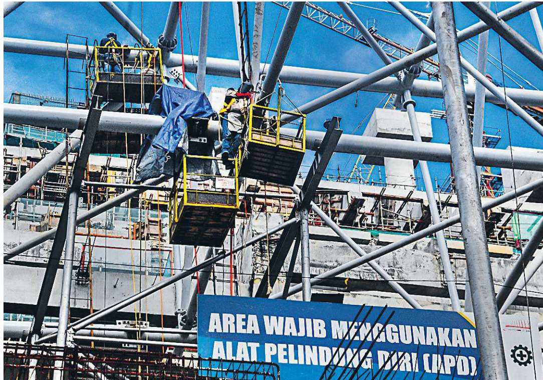
Pekerja menyelesaikan perakitannya rangka atap pembangunan Jakarta International Stadium (JIS) di Papanggo, Tanjung Priok, Jakarta, pekan lalu. Rangka atap tersebut nantinya akan dilengkapi juga dengan fitur
